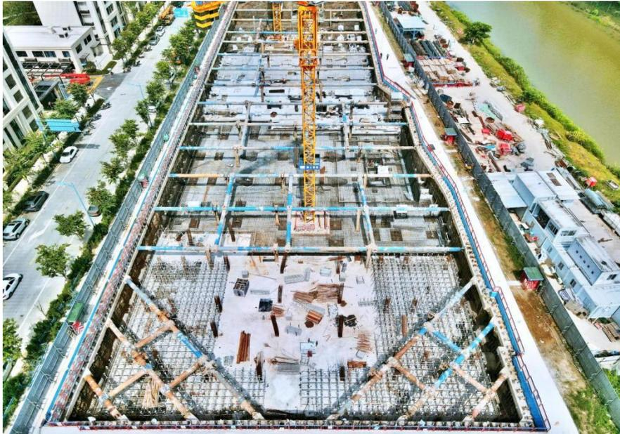
基础施工阶段，项目首次实践 SMW 工法桩加水平钢支撑的围护结构形式，顺利突破技术难点，巧妙化解深基坑施工难题，项目于 2023 年 9 月上旬全面冲出正负零。
